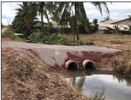
๑๓. วางท่อระบายน้ำ ภายในหมู่ที่ ๓ ตำบลป่าไผ่ บริเวณที่นางนางปราณี รูปทอง
