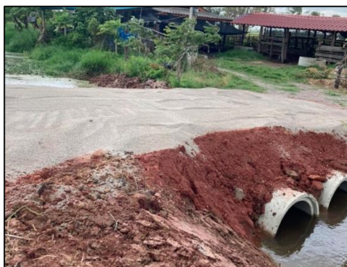
๑๕. วางท่อระบายน้ำภายในหมู่ที่ ๑ ตำบลป่าไผ่ บริเวณทางเข้าบ้านนายก้อน เหมาะสม
