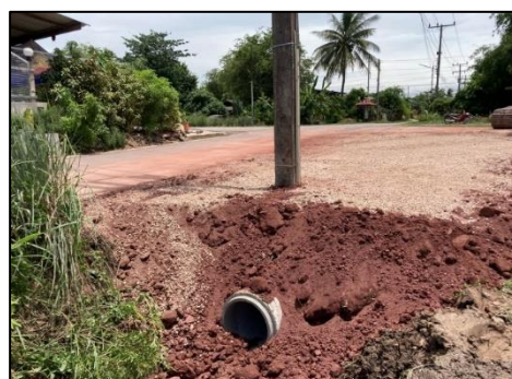
๒๔)โครงการวางท่อระบายน้ำคอนกรีตเสริมเหล็ก มอก.ชั้น ๓ ภายในหมู่ที่ ๕ ตำบลป่าไถ่ บริเวณบ้าน นางรุ่งราตรี อิมโอสฐ์
