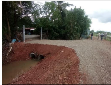
๒๓)โครงการวางท่อระบายน้ำคอนกรีตเสริมเหล็ก มอก.ชั้น ๓ ภายในหมู่ที่ ๕ ตำบลป่าไถ่ บริเวณบ้านกระจำดวง
