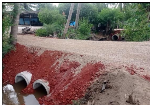
๒๔)โครงการวางท่อระบายน้ำคอนกรีตเสริมเหล็ก มอก.ชั้น ๓ ภายในหมู่ที่ ๕ ตำบลป่าไถ่ บริเวณบ้าน นางรุ่งราตรี อิมโอสฐ์
