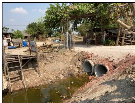
๑๒)โครงการวางท่อระบายน้ำคอนกรีตเสริมเหล็ก มอก.ชั้น ๓ ภายในหมู่ที่ ๕ ตำบลป่าไถ่ บริเวณบ้านนายสมชาย โชติช่วง
