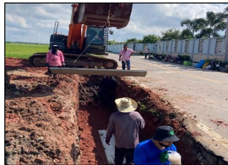
๑๓. โครงการวางท่อระบายน้ำคอนกรีตเสริมเหล็ก มอก.ชั้น ๓ ภายในหมู่ที่ ๓ ตำบลป่าไถ่ บริเวณถนนสายป่าไถ่-ดอนมะนนท์
