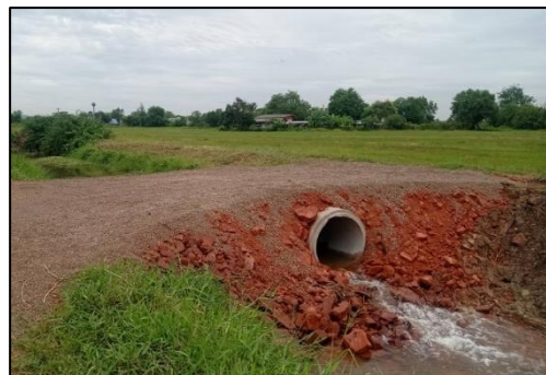
๑๙. โครงการวางท่อระบายน้ำคอนกรีตเสริมเหล็ก มอก.ชั้น๓ ภายในหมู่ที่ ๑ ตำบลป่าไถ่ บริเวณที่นายนายเสน่ห์ ราชสิงโ
