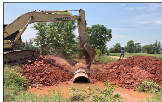
๑๕. โครงการวางท่อระบายน้ำคอนกรีตเสริมเหล็ก มอก.ชั้น ๓ ภายในหมู่ที่ ๕ ตำบลป่าไถ่ บริเวณคลองชลประทาน บ่อกุ่ม จำนวน ๓ จุด
