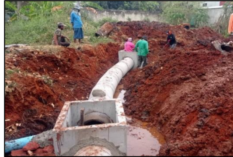
๙. โครงการวางท่อระบายน้ำคอนกรีตเสริมเหล็ก มอก.ชั้น ๓ ภายในหมู่ที่ ๒ ตำบลป่าไถ่ บริเวณคลองเลียบทางรถไฟ
