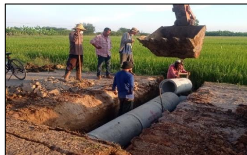
๑๑. โครงการวางท่อระบายน้ำคอนกรีตเสริมเหล็ก มอก.ชั้น ๓ ภายในหมู่ที่ ๓ ตำบลป่าไถ่ บริเวณคลองเลียบทางรถไฟที่นางสาวสังเวียน ทนนานนท์
