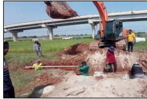
๑๓. โครงการวางท่อระบายน้ำคอนกรีตเสริมเหล็ก มอก.ชั้น ๓ ภายในหมู่ที่ ๓ ตำบลป่าไถ่ บริเวณถนนสายป่าไถ่-ดอนมะนนท์
