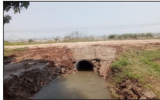
๑๕. โครงการวางท่อระบายน้ำคอนกรีตเสริมเหล็ก มอก.ชั้น ๓ ภายในหมู่ที่ ๕ ตำบลป่าไถ่ บริเวณคลองชลประทาน บ่อกุ่ม จำนวน ๓ จุด
