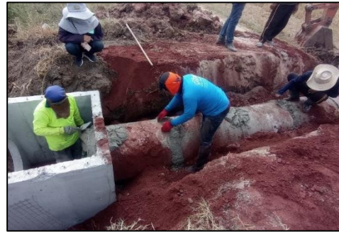
๑๐. โครงการวางท่อระบายน้ำคอนกรีตเสริมเหล็ก มอก.ชั้น ๓ ภายในหมู่ที่ ๑ ตำบลป่าไถ่ บริเวณคลองเลียบทางรถไฟ
