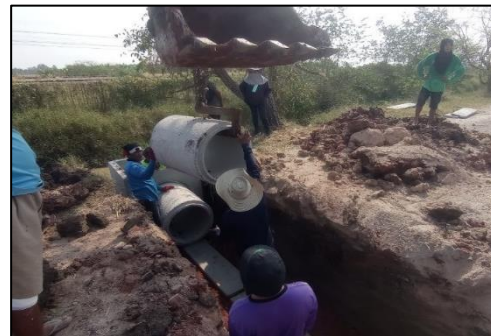
๑๑. โครงการวางท่อระบายน้ำคอนกรีตเสริมเหล็ก มอก.ชั้น ๓ ภายในหมู่ที่ ๓ ตำบลป่าไถ่ บริเวณคลองเลียบทางรถไฟที่นางสาวสังเวียน ทนนานนท์
