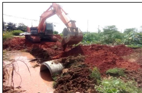
๑๙. โครงการวางท่อระบายน้ำคอนกรีตเสริมเหล็ก มอก.ชั้น๓ ภายในหมู่ที่ ๑ ตำบลป่าไถ่ บริเวณที่นายนายเสน่ห์ ราชสิงโ
