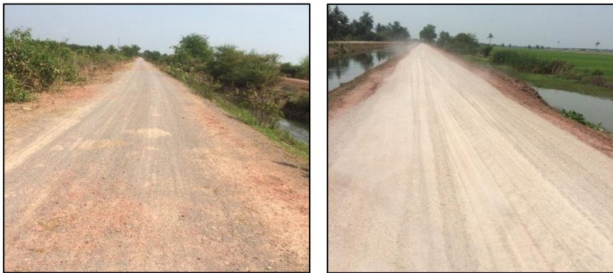
๕. ซ่อมแซมถนนโดยลงหินคลุก พร้อมปรับเกลี่ยเรียบ ภายในหมู่ที่ ๓ ตำบลป่าไถ่
