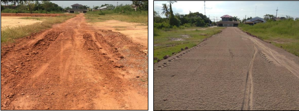
๔. ซ่อมแซมถนนโดยลงหินคลุก พร้อมปรับเกลี่ยเรียบ ภายในหมู่ที่ ๓ ตำบลป่าไถ่
