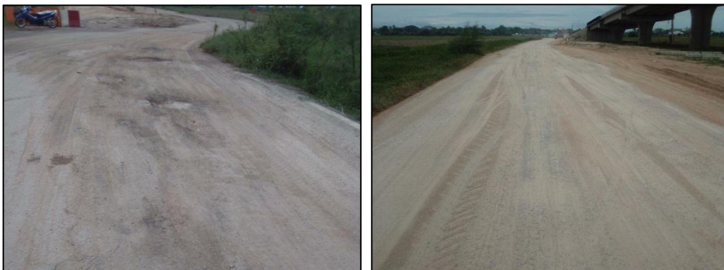
๖. ซ่อมแซมถนนโดยลงหินคลุก พร้อมปรับเกลี่ยเรียบ ภายในหมู่ที่ ๓ ตำบลป่าไถ่
