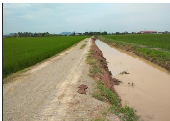
๗๔. ขุดลอกคลองภายในหมู่ที่ ๕ และหมู่ที่ ๓ ตำบลป่าไถ่บริเวณคลองบ้านหนองเกตู-ป่าไถ่
