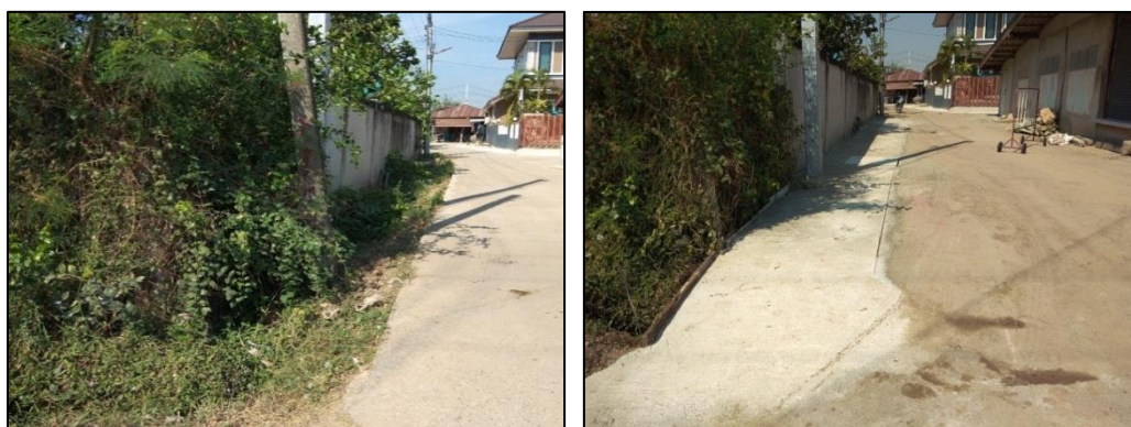
๑๕. วางท่อระบายน้ำคอนกรีตเสริมเหล็ก ภายในหมู่ที่ ๓ ตำบลป่าไถ่บริเวณบ้านนางเครือวัลย์ กลิ่นฟุ้ง
