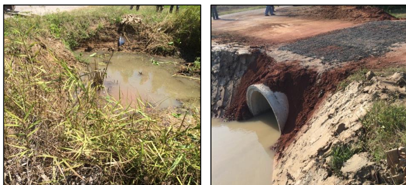
๑๔. วางท่อระบายน้ำคอนกรีตเสริมเหล็ก ภายในหมู่ที่ ๓ ตำบลป่าไถ่บริเวณบ้านนายเชื่อม รูปทอง
